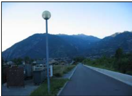
Route de la digue actuellement
